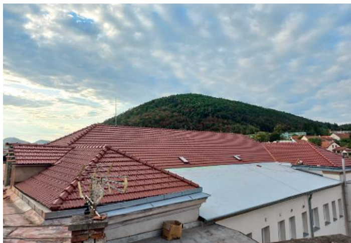
Opravy střechy tělocvičny
