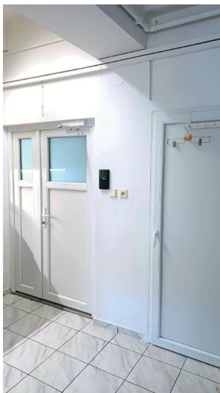
Nové dveře včetně zabezpečovacího zařízení
