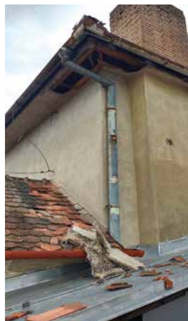
Technické posouzení upozorňuje také na dožitou střechu, římsy a klempířské prvky společenského sálu
