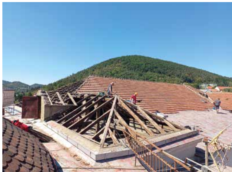
Probíhající práce na střeše nad tělocvičnou
