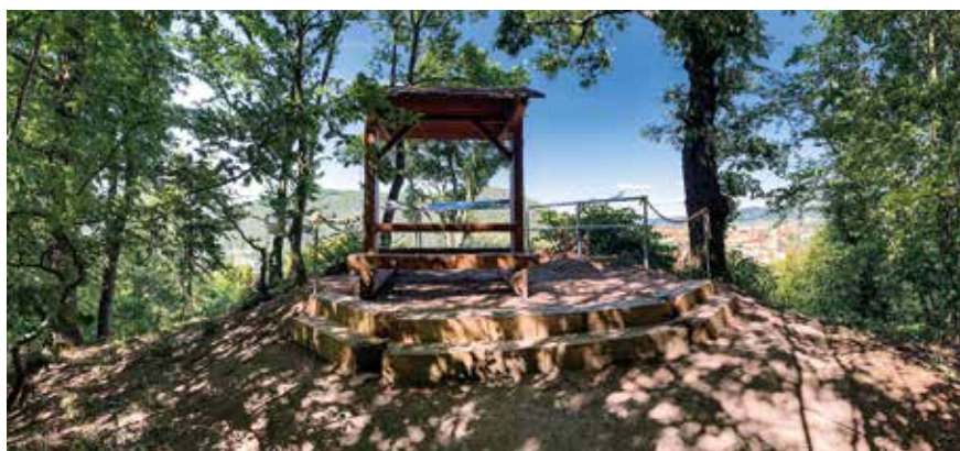
Dřevěný přístřešek na vyhlídce
