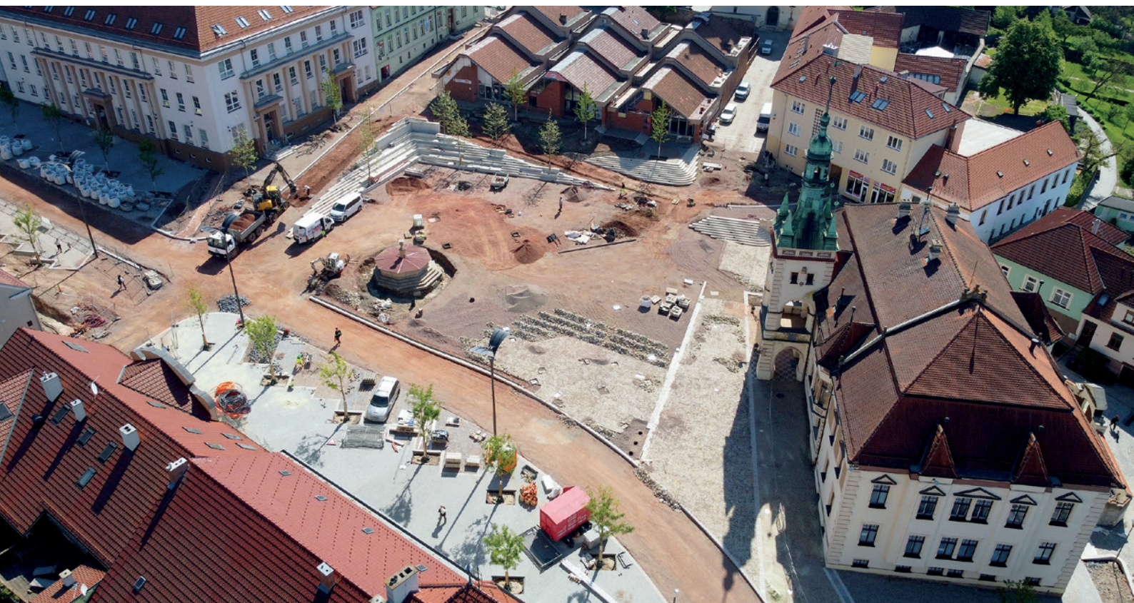
Obrisy nového náměstí Míru už jsou zřetelné. Aktuálně stavební firma pracuje především na dláždění povrchů. Hotové a otevřené má být náměstí o letních prázdninách. Foto: Pavel Navrátil
