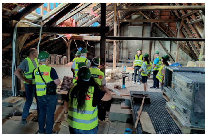
Zastupitelé si rekonstruovanou budovu Hotelu Květnice prohlédli krátce poté, co byly na půdu umístěny klimatizační jednotky
