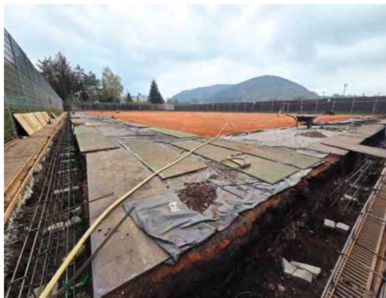
Budování betonových základů pro novou halu přes čtyři kurty
