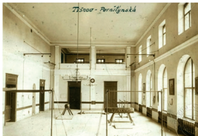
Původní prostor tělocvičny v budově, 1898
