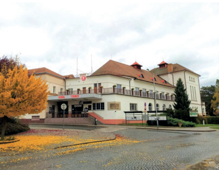
Sokolovna před zahájením stavebních prací na ulici Riegrova, 2020
