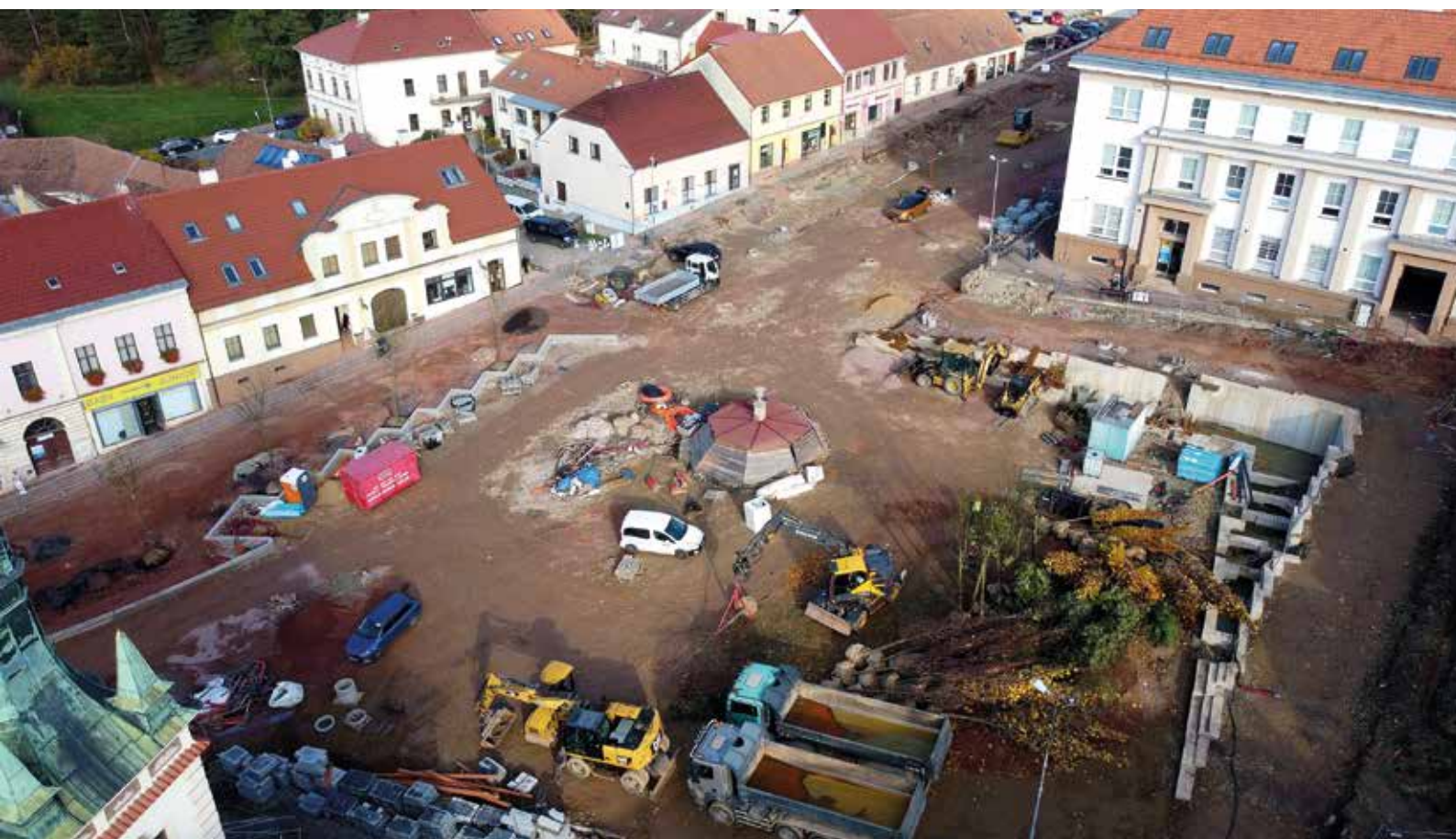
Práce na revitalizaci náměstí Míru v listopadu pokračovaly především výsadbou vzrostlých stromů, dokončováním ulice Kostelní a dlážděním chodníků. V návaznosti na to došlo ke změnám pěších tras. Více se o tom dočtete na str. 14 a 15.
