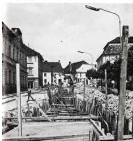
Titulka říjnového čísla 1975 – budování nového kanálu v Janáčkově ulici na fotografii M. Svobody
