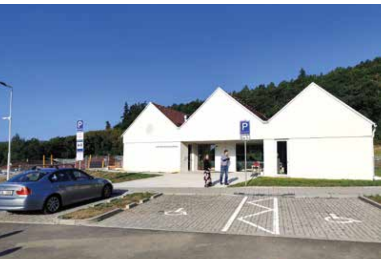
Průčelí vstupu do MŠ Konvalinka
