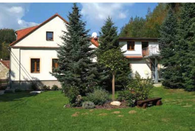
Budova Chráněného bydlení ve Skryjích
