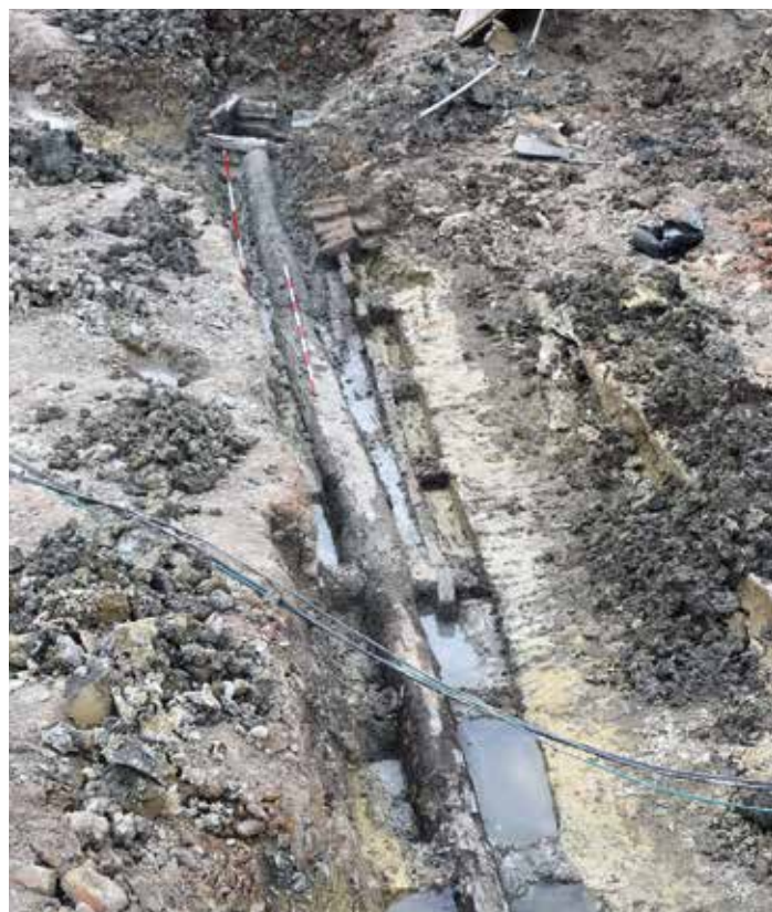
Počátkem září odkryli archeologové v centrální ploše náměstí Míru část dřevěného potrubí – pravděpodobně jde o vodovod z konce 19. století, který napájel tišnovské kašny a farskou studánku
