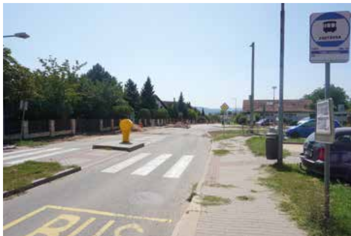
V ulicích Kukýrna a Lomnická probíhají práce spojené s vytvořením nového asfaltového povrchu komunikace
