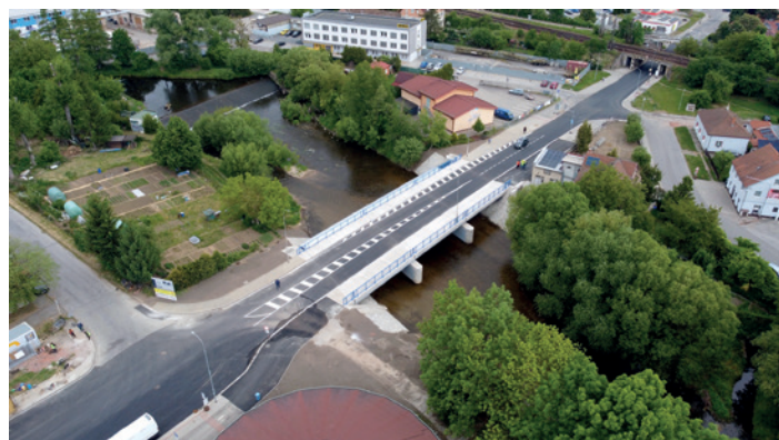
Most po opravě
