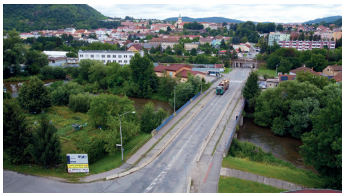
Most před opravou
