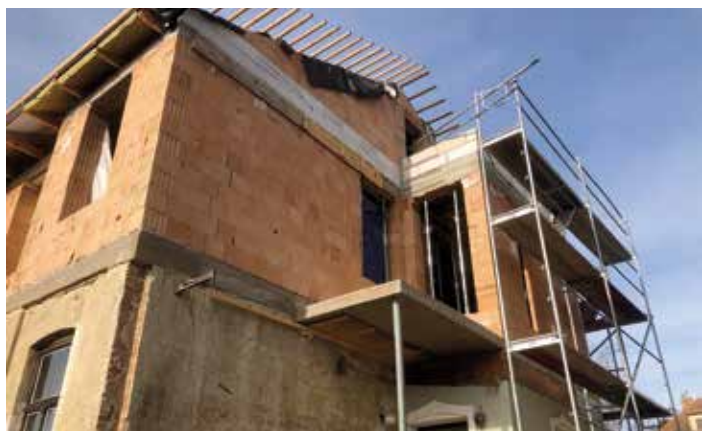
Nástavba na budově OCH Tišnov na ulici Tyršova roste
