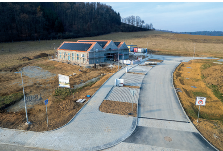
Současný stav školky při výstavbě
