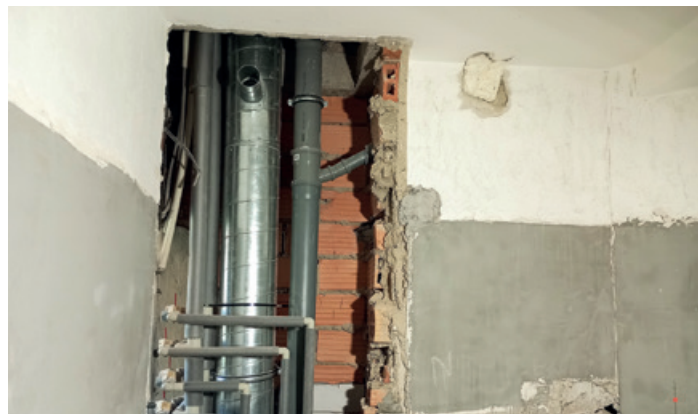
Rekonstrukce rozvodů vody, odpadního potrubí a vzduchotechniky v CSS Tišnov.
