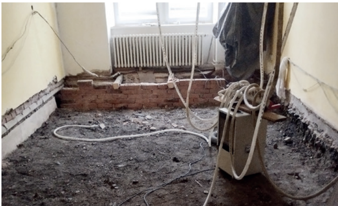
Práce na odstranění škod.
