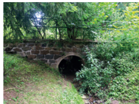
Mostek a propust bývalé železnice v Chudčicích.
