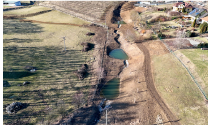
Letecký pohled na lokalitu po realizaci.
