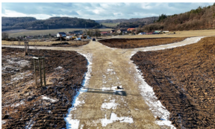
Probíhající zemní práce – podzim a zima 2023.
