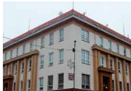
Na tomtéž místě stojí budova někdejší zemědělské školy, kde byla ohlášena časovaná nálož. Foto: SŠ a ZŠ Tišnov
