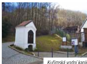
Kuřimská vodní kaple
