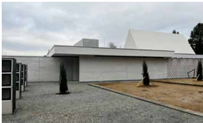
Zelená střecha smuteční síně zadrží srážkovou vodu a zlepší mikroklima budovy.
