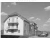
Novostavba bytu 2+kk Tišnov Dlouhá, 73 m 2 , 2.NP, balkon 8 m 2 2.149.000 Kč
