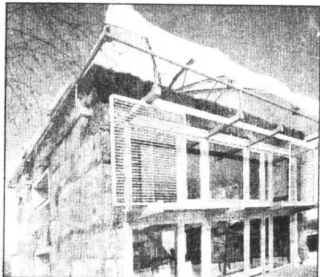
len slaměnými balíky o síle 600 mm, chráněnými pouze jemnou kovovou sítí, která brání přístupu hlodavcům a ptákům. Na střeše jsou balíky v síle 1 m.
