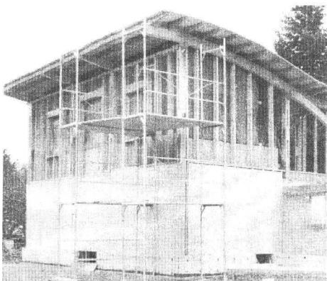
Obvodové stěny domů jsou tvořeny ze dřevěných hranolů, které jsou vyplněny tepelnou izolací o síle cca 30 cm. Z venkovní strany jsou domy omítнутé vápennou omítkou, aby bylo docíleno nejenom pružnosti omítky ale i její prodyšnosti. Z vnitřní strany je stěna omítнутa hliněnou omítkou, která má jedinečnou schopnost udržení příjemného klimatu v místnostech a dokáže dokonce do sebe vázat škodlivé látky ze vzduchu.
