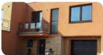
RD 4+1, Předklášteří CP 284 m 2 , garáž, bazén, venk. posezení 2,999.000,- Kč
