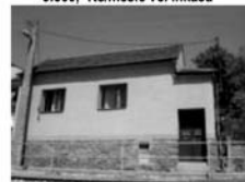
RD 3+1 Hradčany u Tišnova možno i s nájemníky, pozemek 501 m 2 1.399.000,- Kč
