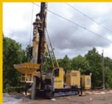
Zřízení šterkopiskových pilot
