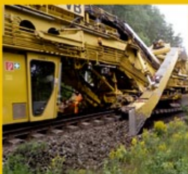
Odtěžení šterkového lože (RM90D VB)
