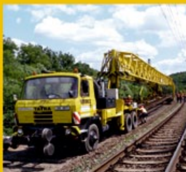
Trhání kolejových polí (PKP)
