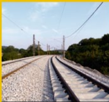
Nově položená kolej č. 2
