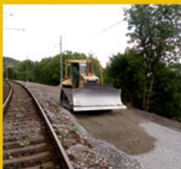
Zřízení vrstvy šterkodrtě
