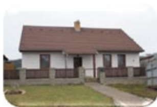
RD 3+kk, Hradčany, Čebínská nízkoenergetický, zateplený RD, CP 680 m 2 , 3,199.000,- Kč
