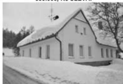
Rodinný dům 6+1 Nová Ves po částečné rekonstrukci, CP 1.790 m 2 , 1.690.000,- Kč
