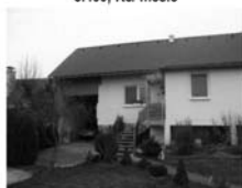
RD 4+1 Horní Loučky po kompletní rekonstrukci, CP 386 m 2 , 2.599.000,- Kč
