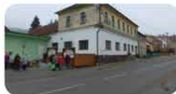
RD Kanice 5+2 + restaurace v přízemí CP 441 m², po částečné rekonstrukci 2.500.000,- Kč
