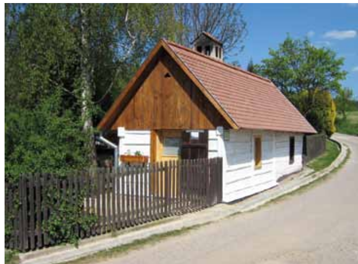
Bývalá sušárna ovoce, roubená stavba.
