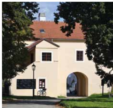
Opravený vstupní trakt do areálu.
