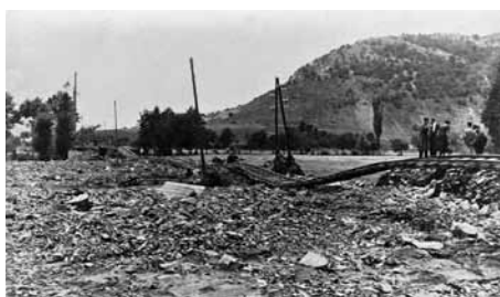
Železniční trať mezi Květnicí a Dřínovou, stržená při červenkové povodni roku 1922.
