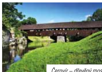
Černvír – dřevěný most
