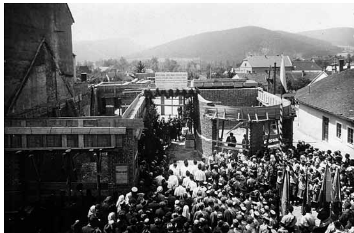
Katolický dům – oficiální zahájení stavby v červnu 1938.
