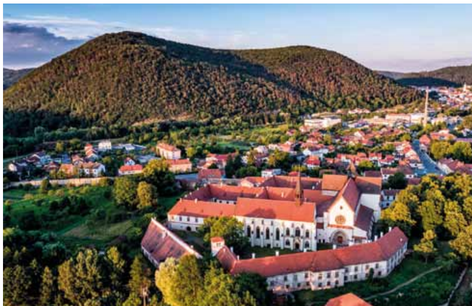
Letecký pohled na areál kláštera Porta coeli.
