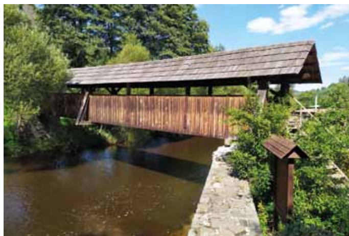
Švařec – roubená krytá lávka přes Svatku.
