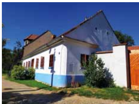
Lomnice – ulice Poštovská, č. p. 22.
