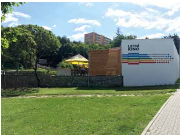
Rekonstrukce restaurace a terasy.
