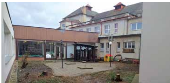
Atrium sokolovny bez stromů.
