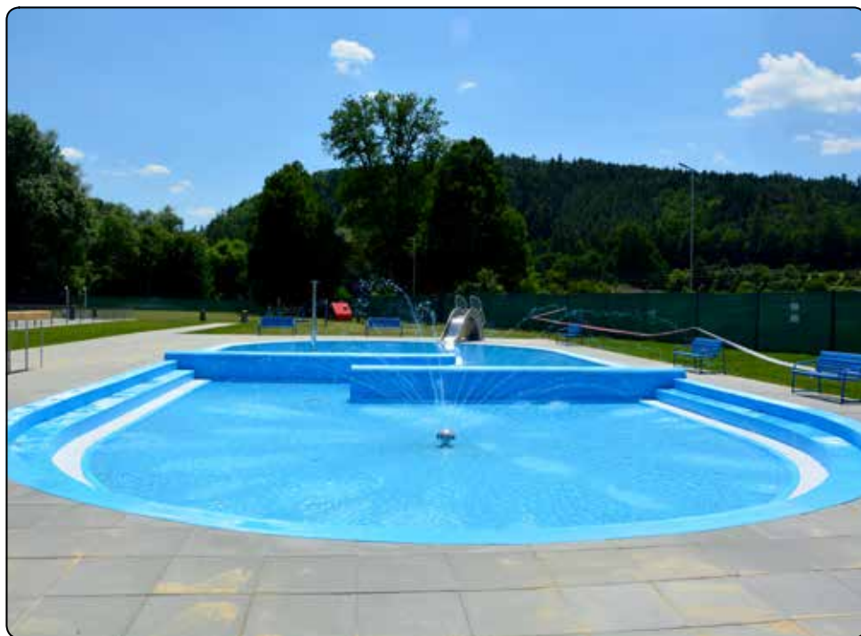
Zrekonstruované brouzdaliště na tišnovském koupališti. Foto: Roman Skřeppek
