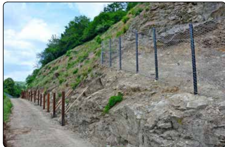
Sanace skalního masivu Květnice by měla být dokončena v červnu. Foto: Roman Skřeppek
