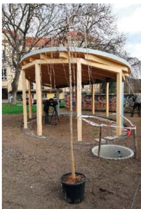
Venkovní učebna v době realizace.
