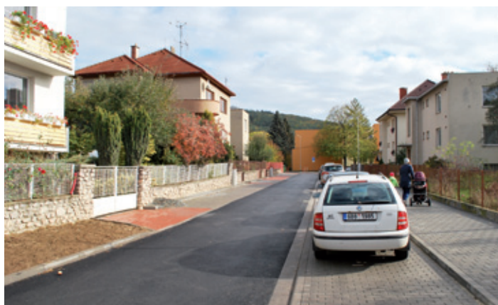
V říjnu byla dokončena rekonstrukce ulice Kvapilova za 2,7 milionu korun. Foto: Roman Skřeppek
