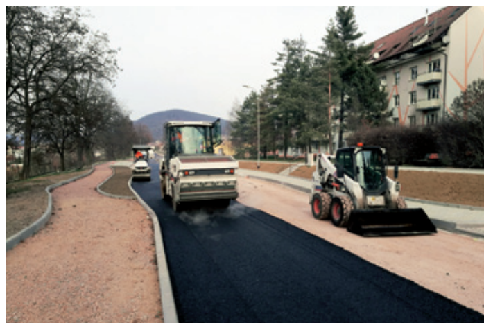
Dokončení rekonstrukce ulice Brněnské je plánováno na květen 2019. Foto: Roman Skřepek
