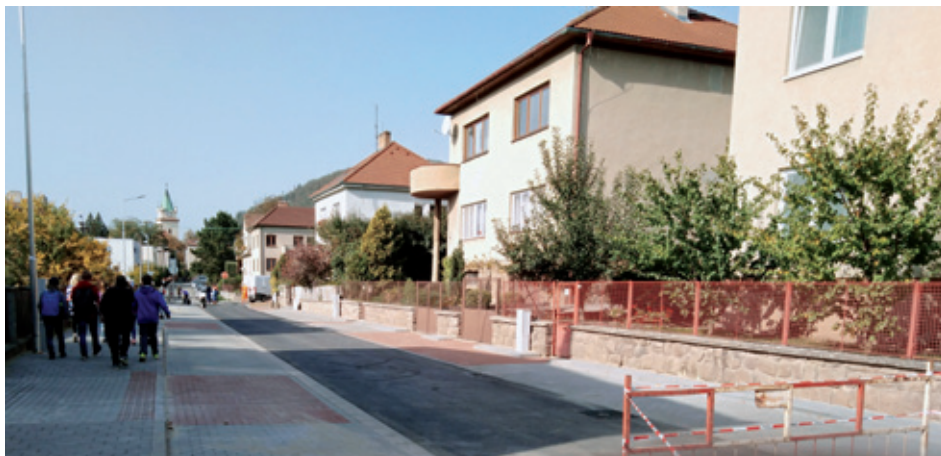
Rekonstrukce Kvapilovy ulice byla dokončena. Celkové náklady stavby činily 2,7 milionu korun. Foto: Eva Jelínková
